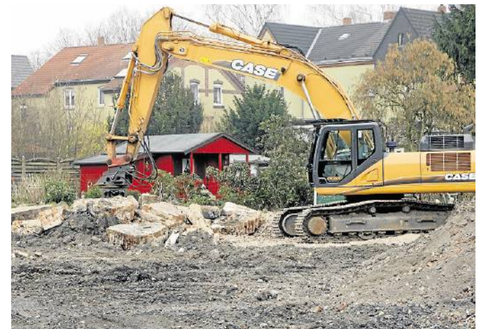
Die Bauarbeiten auf dem Festplatz in Heeren-Werve schreiten voran. Noch sind viele Vorarbeiten zu leisten. Foto: Milk
